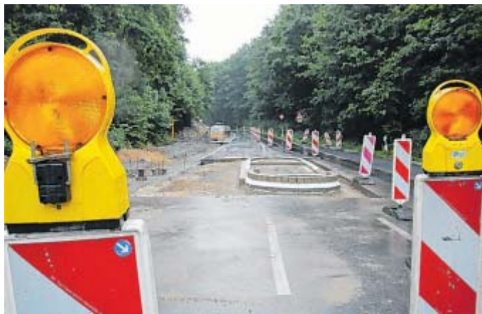
Regenpause: Die erste Mittelinsel auf der Bodelschwingstraße in Höhe der Straße Am Frölenberg ist fast schon fertig. FOTO: SILKE KRÖGER
