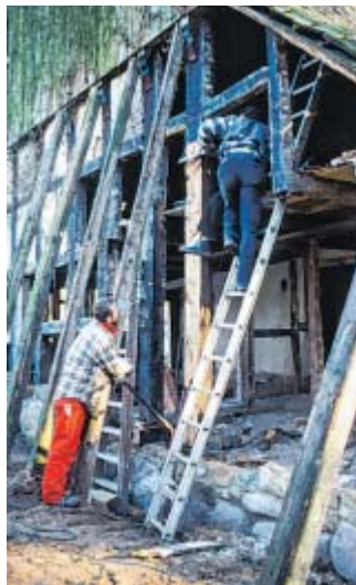
Abgestützt: Das Fachwerk musste neu aufgebaut werden.
