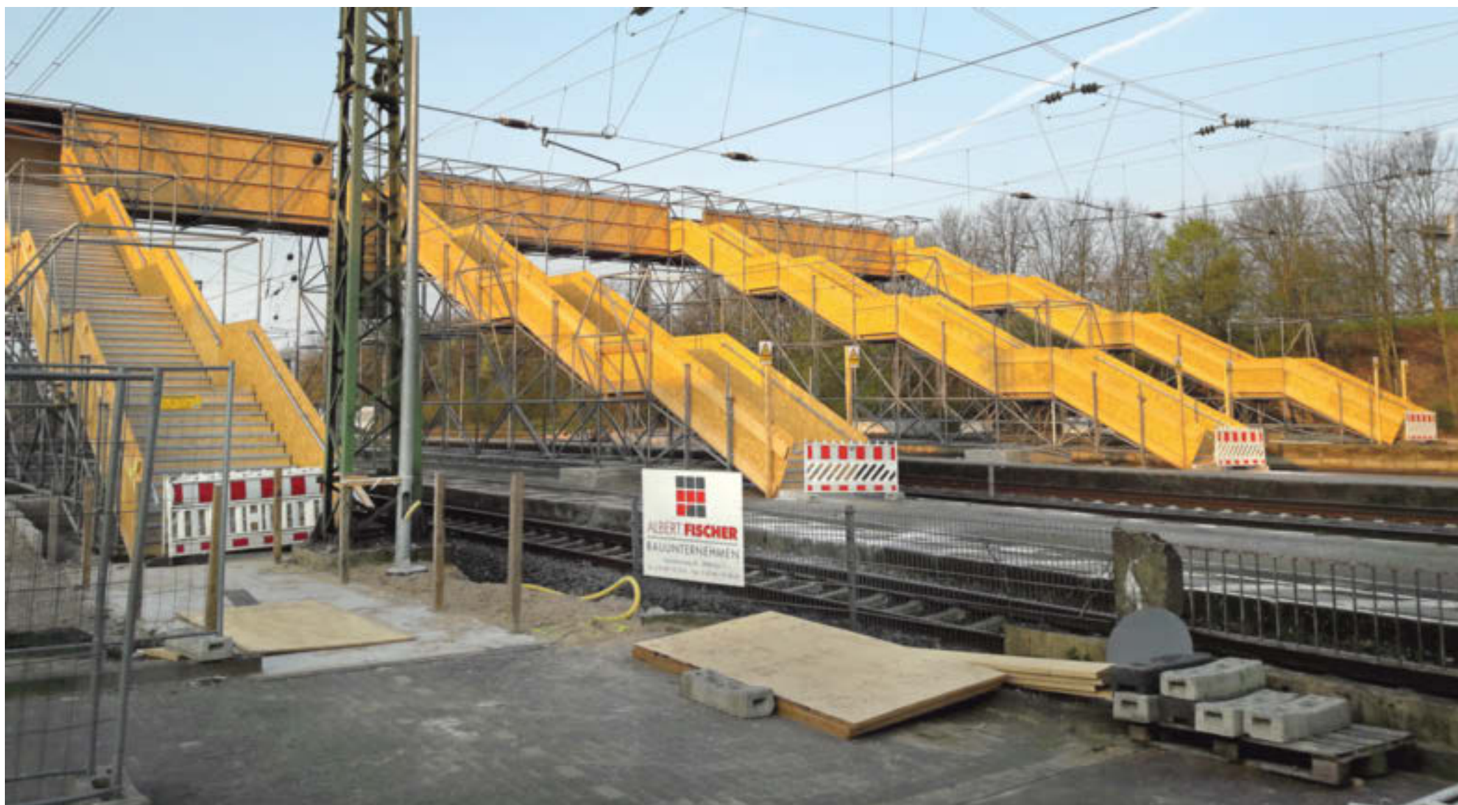
Eindrucksvoll: An der Behelfsbrücke über die Gleise im Brackweder Bahnhof muss noch eine Beleuchtung angebracht werden, bevor sie freigegeben wird.
